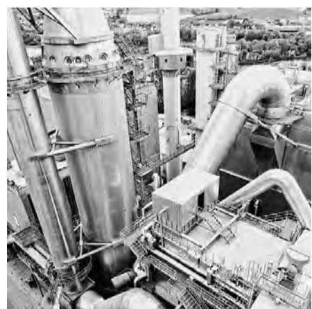
Zu den Projekten des Generalplaners Scherr+Klimke gehörten auch Modernisierungsmaßnahmen im Werk Lengfurt der HeidelbergCement AG.
